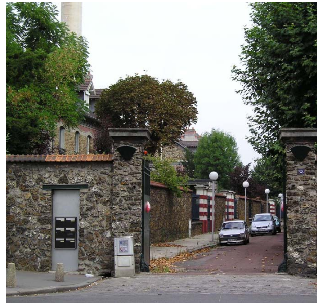
Alignement des pavillons, 1912. Cl. Dép. Seine-Saint-Denis, A. Furio
