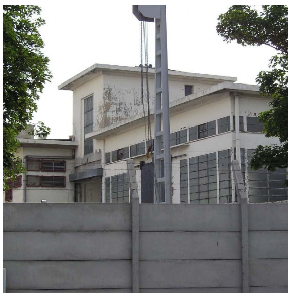
Poste d'interconnexion. Cl. Dép. Seine-Saint-Denis, A. Furio
