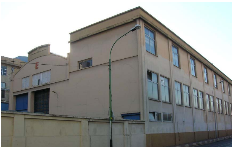
Magasin expédition et menuiserie. L'extension de ce bâtiment respecte la forme d'origine. On retrouve le petit fronton, visible sur tous les magasins, qui dissimule un lanterneau. Cl. Dép. Seine-Saint-Denis, A. Furio
