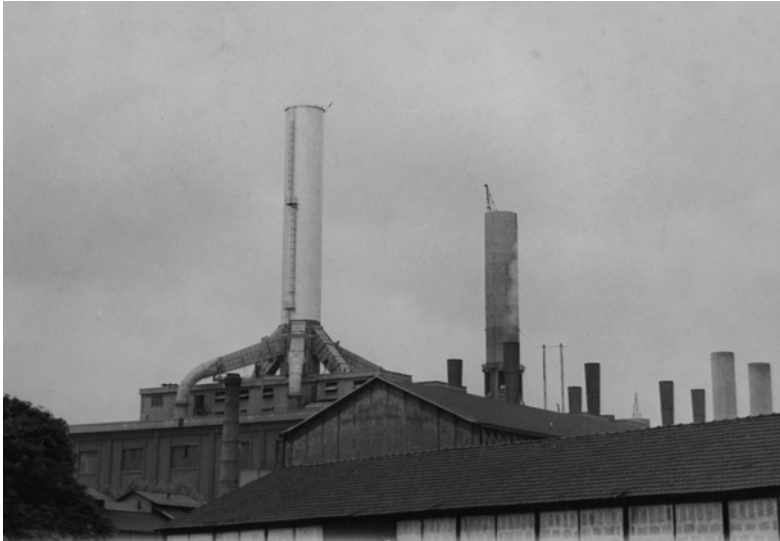
Vue de la centrale électrique dans les années 1950. AM Saint-Ouen
