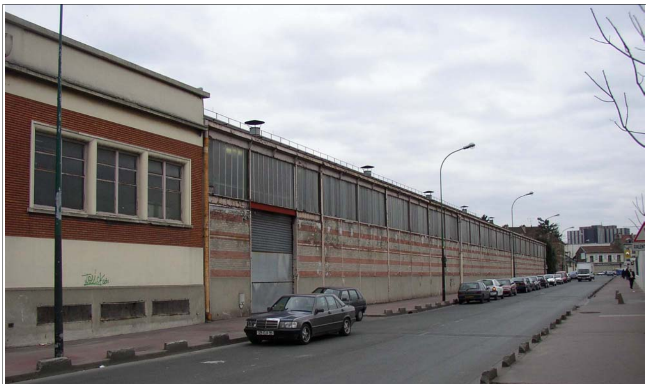
Au premier plan la station de charge des accumulateurs. La halle métallique est aujourd'hui en cours de rénovation. Cl. Dép. Seine-Saint-Denis, A. Furio
