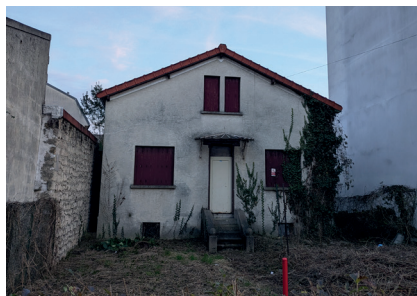
28 avenue Henri-Barbusse Démolition prévue entre le 1 er et 2 ème trimestre 2025
