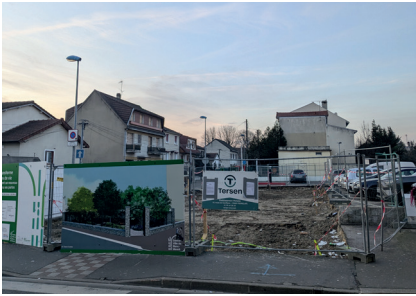
21 avenue Henri-Barbusse Démolition réalisée en 2024
