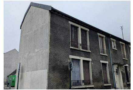
12 rue Paul-Legarros Démolition prévue entre le 1 er et 2 ème trimestre 2025
