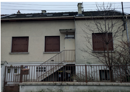
12 avenue Romain-Rolland Démolition prévue entre le 1 er et 2 ème trimestre 2025
